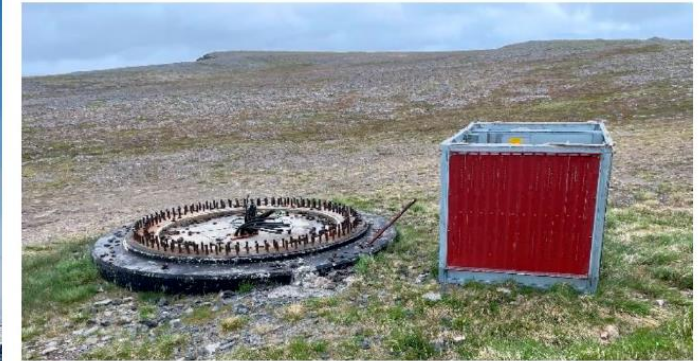
Figur 8 Trafoen ved turbinfundamentet demonteres, deretter bygget
