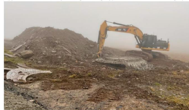
Figur 9 Fundamentene pigges ned før terreng planeres
